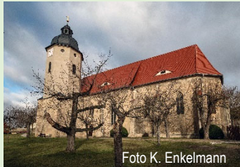
Foto K. Enkelmann Nach Fertigstellung des Daches
