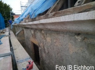
Foto IB Eichhorn Am Beginn der Dacharbeiten 2022
